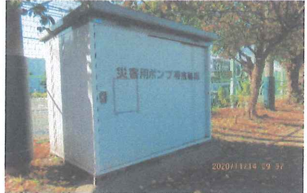
東中学校避難所・地下水くみ上げポンプ収納庫
