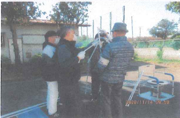
マンホールトイレの組立て中
