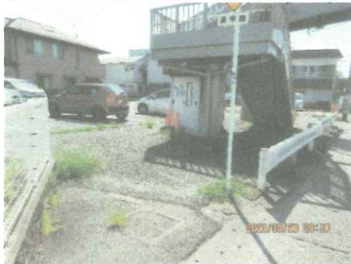
歩道橋廻り現況
