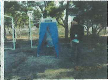
マンホールトイレ
